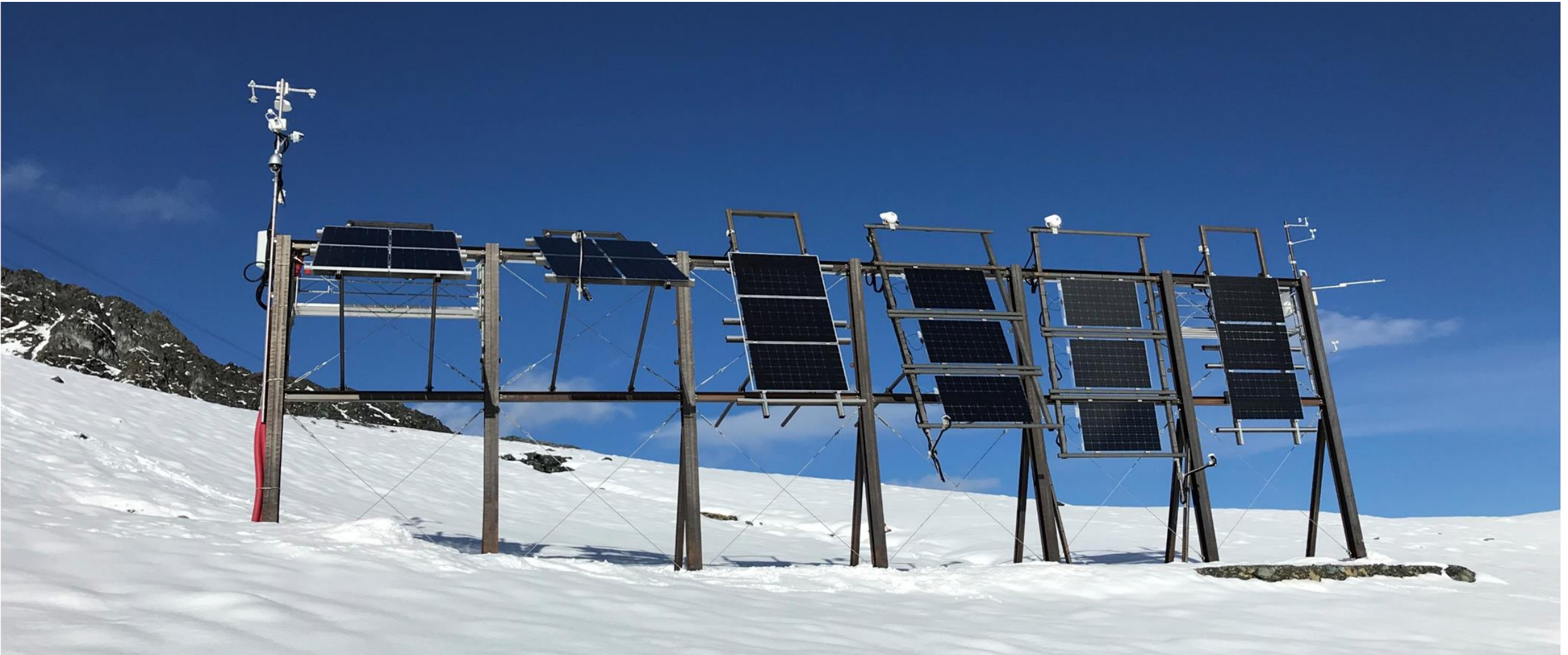
Abb. 1: Ansicht der Versuchsanlage auf 2400 m.ü.M. in Davos von vorne. Alle Module sind gegen Süden ausgerichtet.
