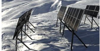
Die Testanlage wurde im November 2023 installiert. Bei den Verankerungen der Panel-Tische wird eine bodenschonende Konstruktion angewandt.
