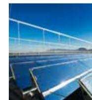
In der sonnenreichen spanischen Region Murcia steht das 2012 in Betrieb genommene, auf der Fresnel-Technologie mit Direktverdampfung beruhende thermische Solarkraftwerk Puerto Errado 2. Es ist unter Schweizer Führung erbaut worden. Neben zwei konventionellen Kraftwerkblöcken umfasst die Anlage ein Solarfeld von rund 302 000 m<sup>2</sup> Spiegelfläche.
